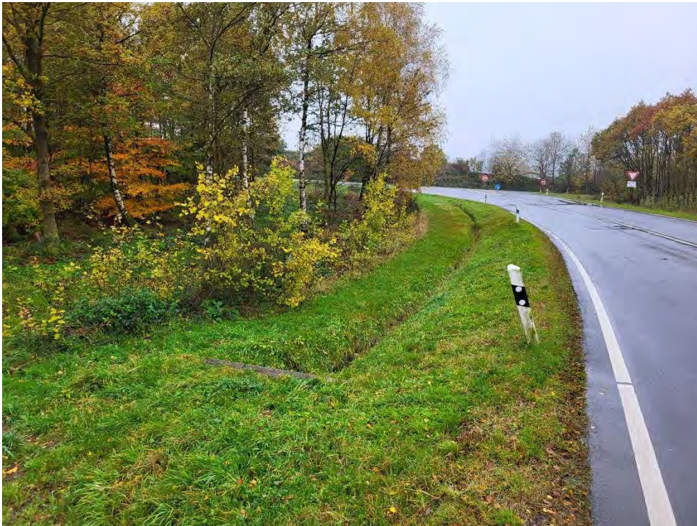
Sichtpunkt 3a: Blick nach Südwesten zur B 260 (bei Ausfahrt), Nässe, Herbst
