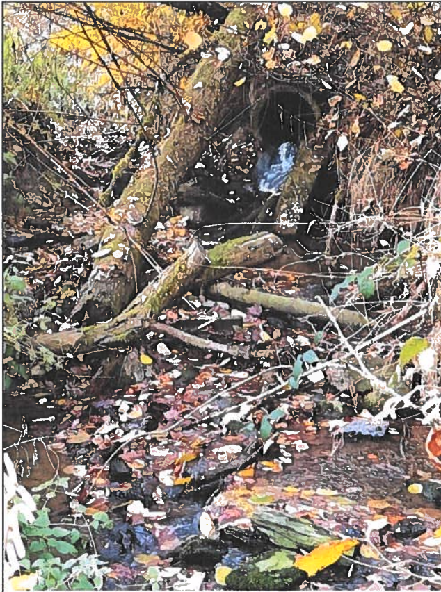
Unterhalb Eileitung KLA Kemel
